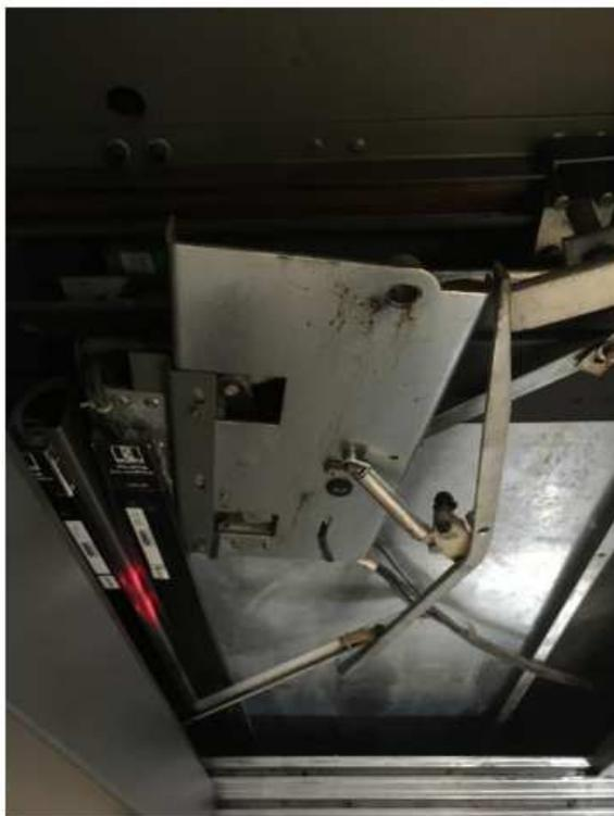
*Figura 4. Dano ao operador e rampa*
