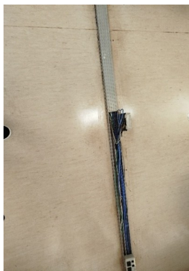
Figura 27 – Piso com irregularidades e cabeamento exposto
