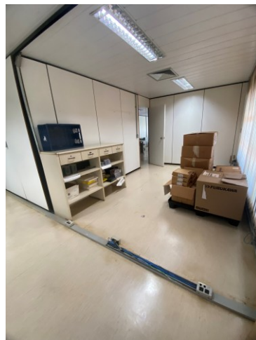
Figura 26 – Piso com irregularidades e cabeamento exposto
