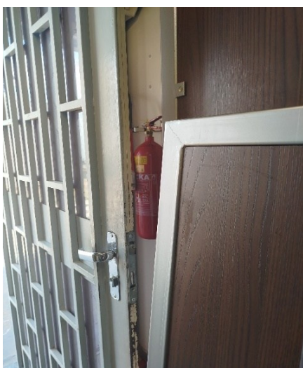
Figura 23 – Único extintor de incêndio do térreo parcialmente obstruído
