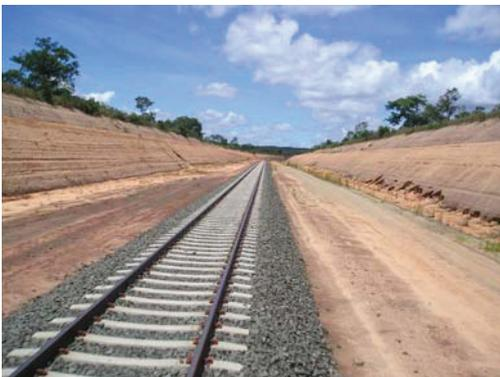
Foto da ferrovia concluída e taludes sem proteção vegetal - lote 05
