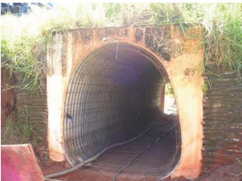
Foto de execução do reforço estrutural em passagem de gado (PG) - lote 05
