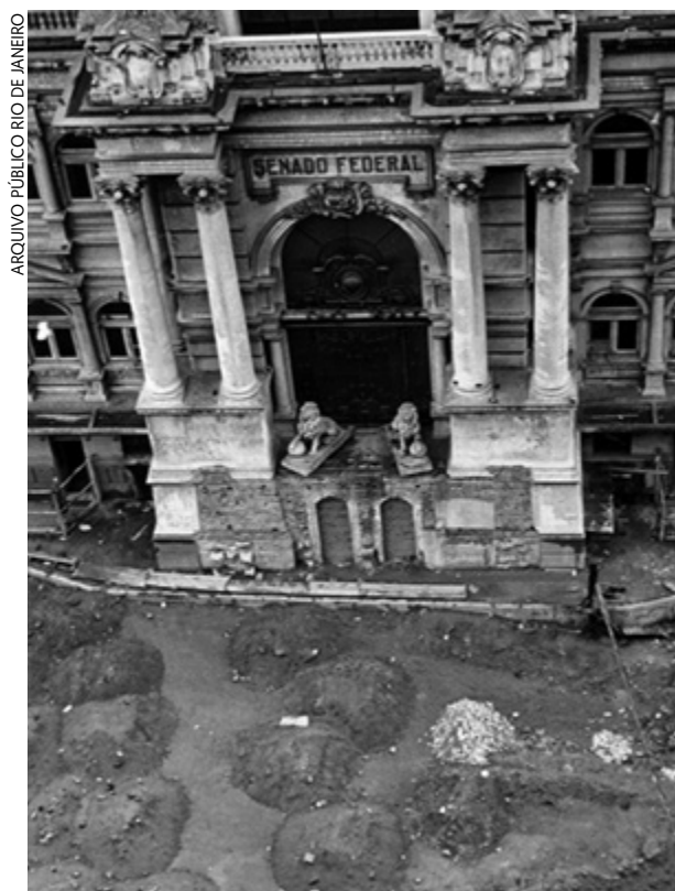
O Palácio Monroe perto de ser derrubado, ainda com os leões de mármore, mas já sem a imponente escadaria
