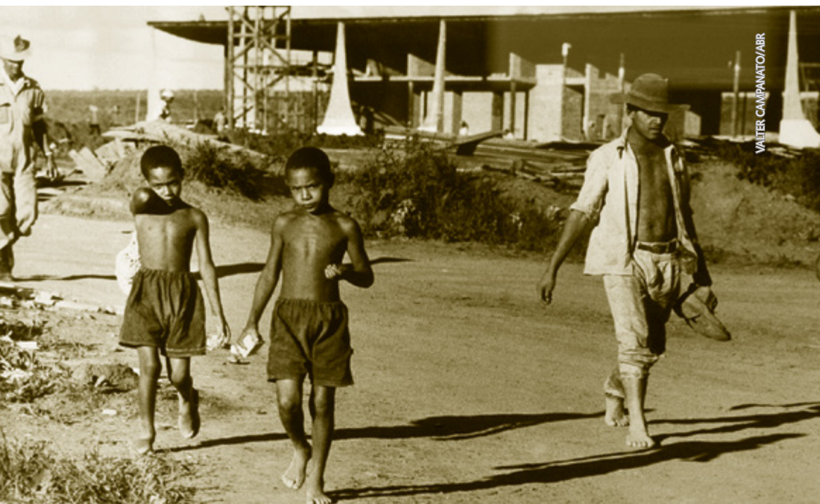
O canteiro de obras do Palácio da Alvorada: capital foi inaugurada em abril de 1960, ainda incompleta
