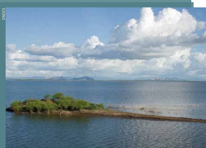
Barragem Armando Ribeiro Gonçalves, construída pelo Dnocs para garantir a perenidade do fluxo do Rio Piranhas-Açu
