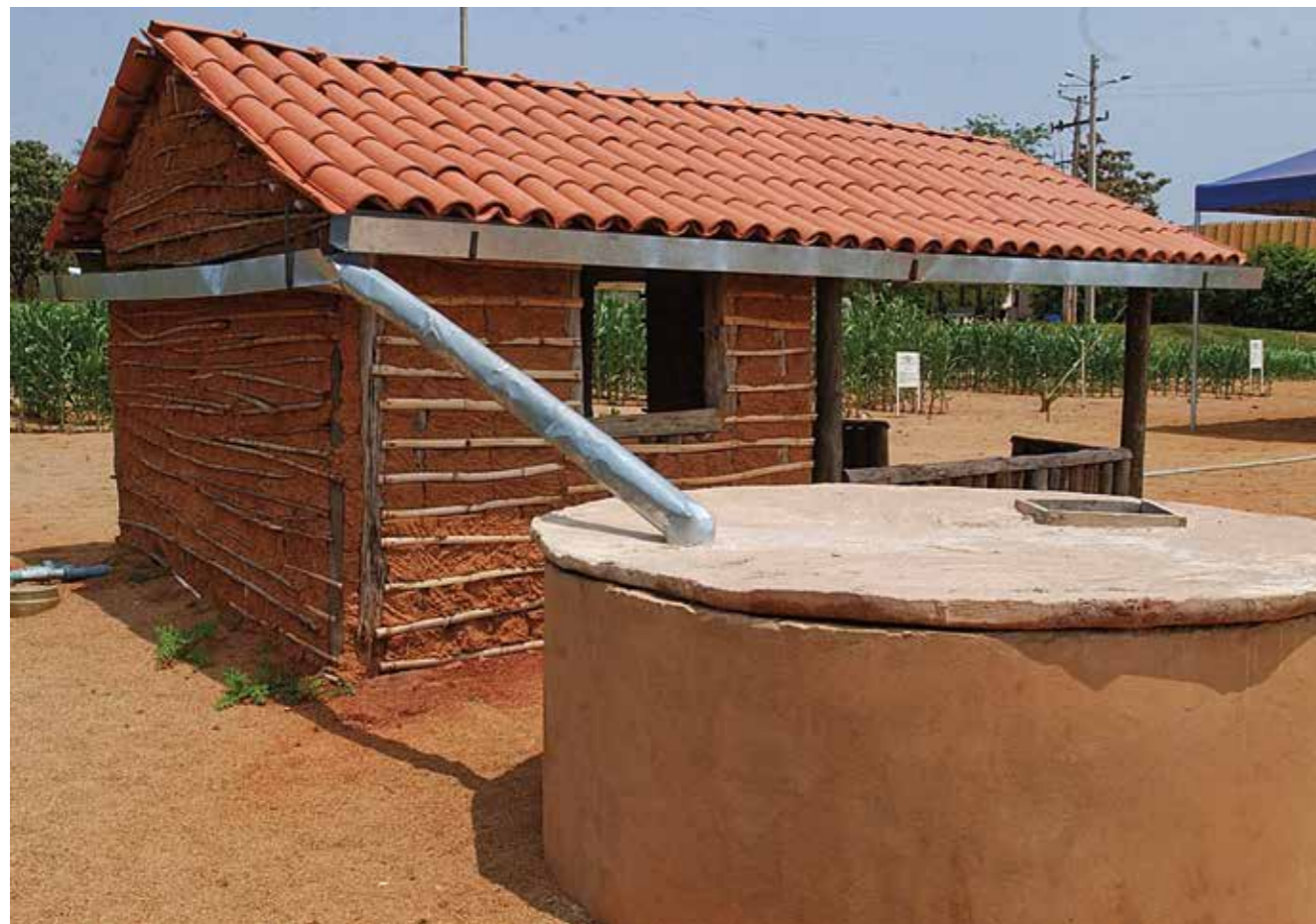
Captação da água da chuva com calhas e canos: de 2011 a 2014, foram construídas quase 700 mil cisternas no Nordeste
