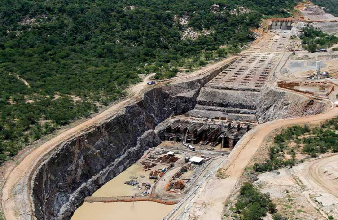
Obras em canal do Rio São Francisco, em Salgueiro (PE): projeto deveria ter sido inaugurado em 2012
