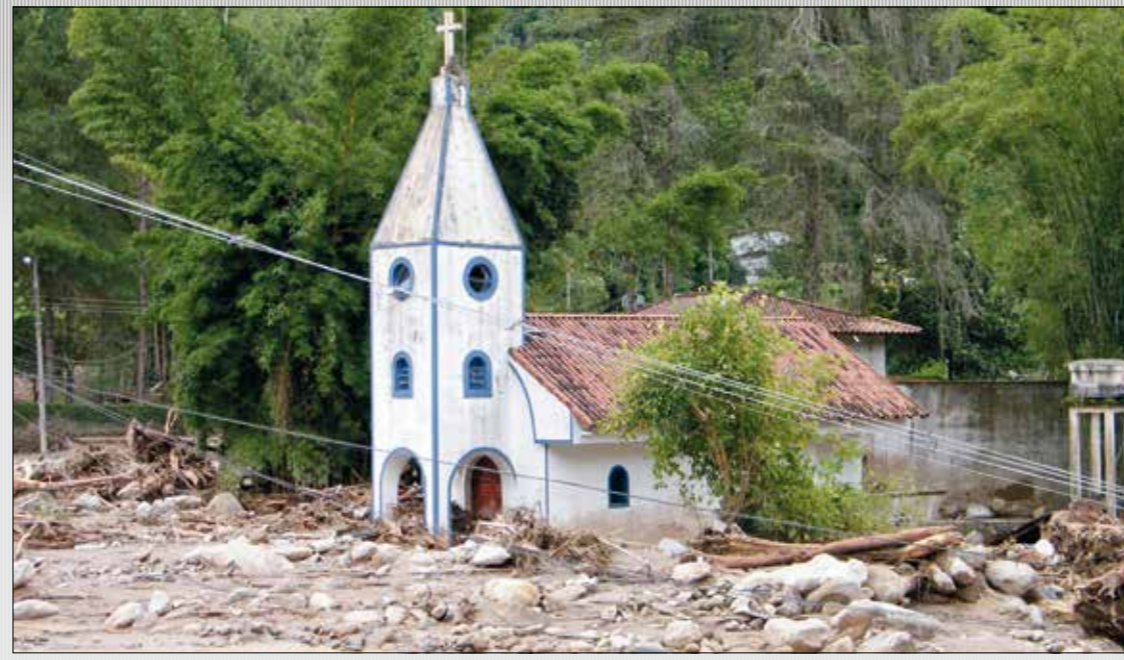
Igreja atingida por lama em Teresópolis, uma das cidades fluminenses que sofreram com deslizamentos em janeiro de 2011
