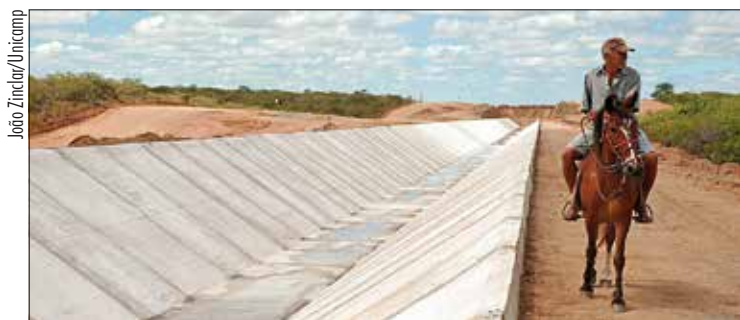
Obra no Rio São Francisco receberá mais verba para levar água ao sertão
