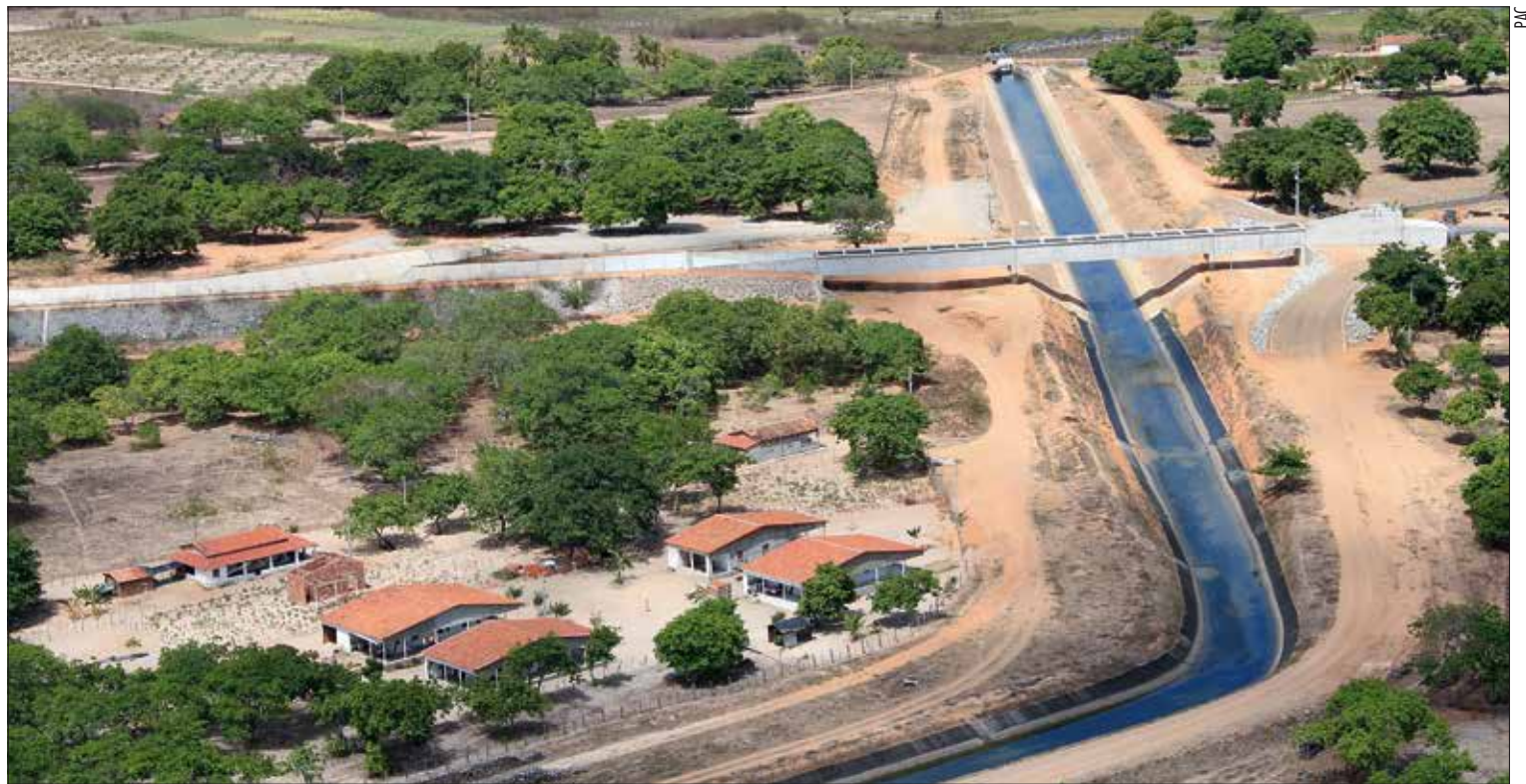
Canais e túneis transpoem águas para atender municípios no Nordeste que sofrem com a seca: obra no Rio São Francisco é uma das ações beneficiadas pela MP 709
